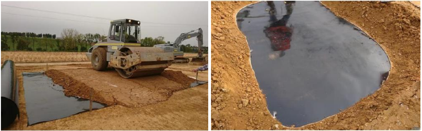
Figure 9. Réalisation d'une planche de convenance pour valider le géotextile de protection situé sur la géomembrane (Photo : YGD Conseil)
