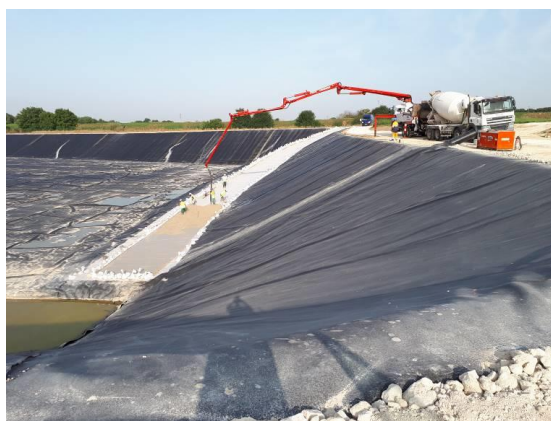
Figure 14. Coulage d'une dalle béton sur la rampe d'accès interne et surcreusement au point bas du bassin pour permettre la vidange du bassin à partir du futur radeau de pompage
