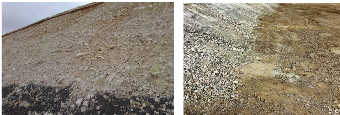
Figure 11. Exemple de supports non réceptionnés car présentant trop de risques d'endommagement du DEDG (Photographies : YGD Conseil)
