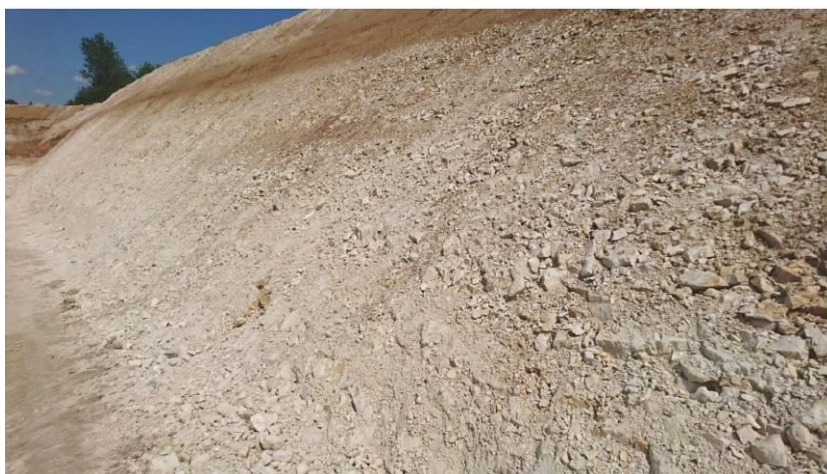
Figure 5. État de surface d'un support sur talus raide nécessitant le choix d'un géotextile de protection sous géomembrane plus performant que celui prévu au marché (géosynthétique de protection n°3)
