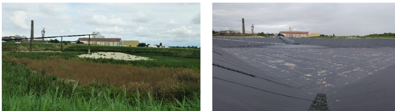
Figure 6. Photographie de l'ancien bassin à écumes (à gauche) et du bassin à eaux condensées rénové et agrandi (à droite) – Photos Arcadis
