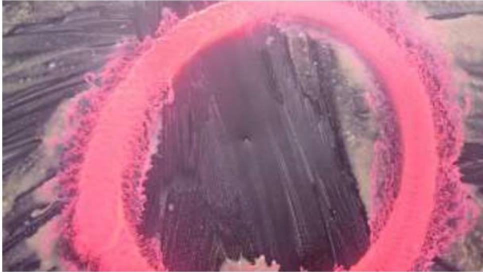
Figure 18. Perforation millimétrique détectée par méthode de l'arc électrique (Photographie : YGD Conseil)
