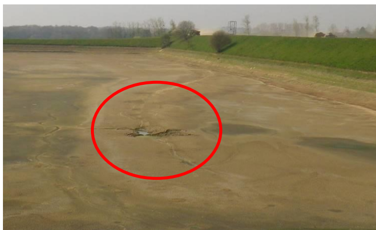
Figure 3. Exemple d'indice de voie de circulation préférentielle de l'eau à la surface des terres décantées
