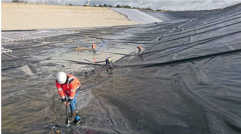
Figure 16. Opération de contrôle de soudure sur géomembrane en PEHD par mise en pression du canal central (Photographie : YGD Conseil)
