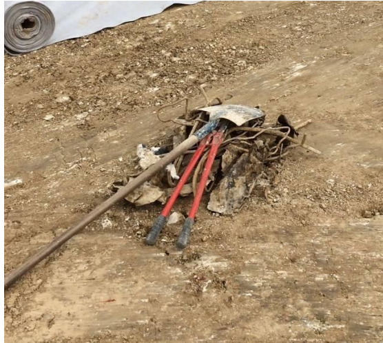
Figure 12. Exemple d'éléments métalliques parasites retrouvés sur le support (Photographie : YGD Conseil)
