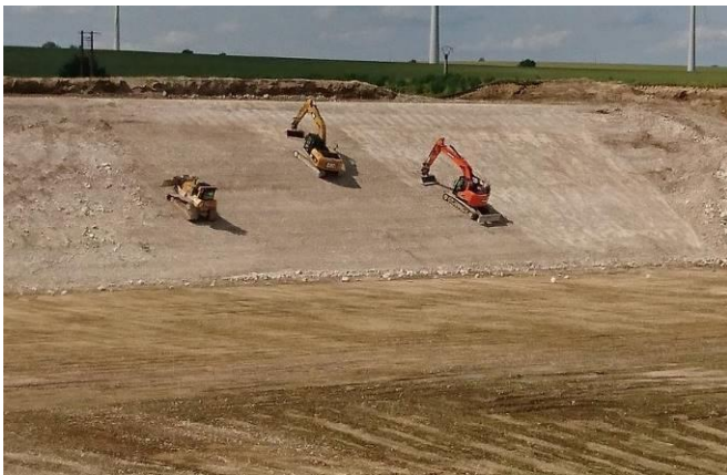
Figure 13. Broyage au bull suivi d'un lissage au godet (à gauche), broyage et compactage (à droite) (Photographies : YGD Conseil)
