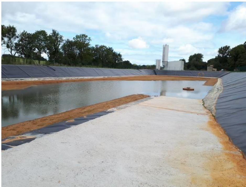
Figure 10. Bassin entièrement étanché par géomembrane avec couche de circulation en matériaux naturels traités (Photo : Arcadis)
