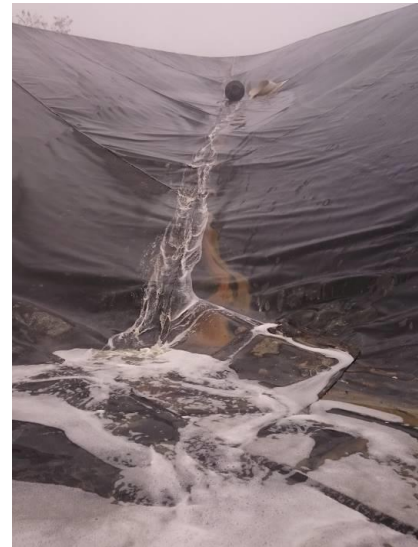
Figure 15. Géomembrane tendue en pied de talus et dans un angle (Photographies : YGD Conseil)
